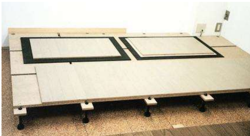
【建築下地（床）の施工例】
