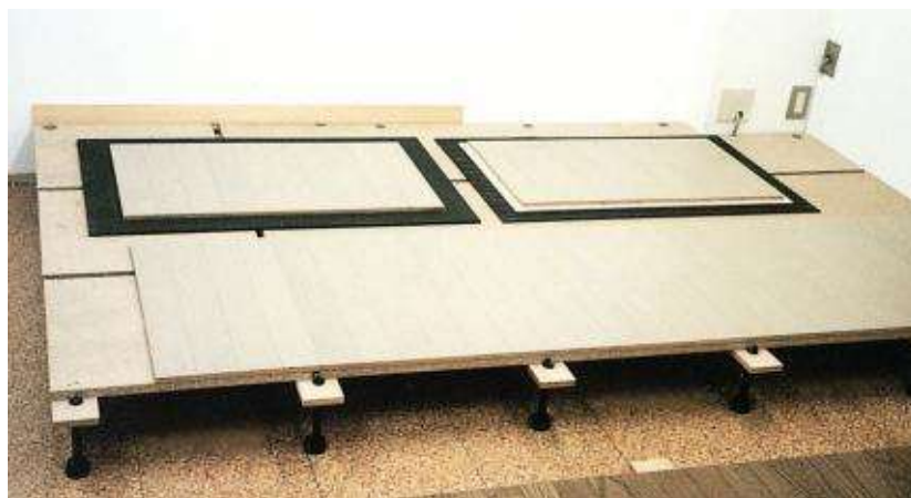
【Construction Example : Floor substrate material】
